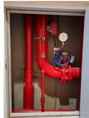
ระบบท่อรับน้ำดับเพลิงจากถังเก็บน้ำชั้นใต้ดิน B2
