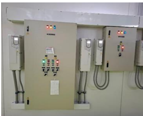
รูปที่ 26 อุปกรณ์ปรับความเร็วรอบมอเตอร์ (VSD)
