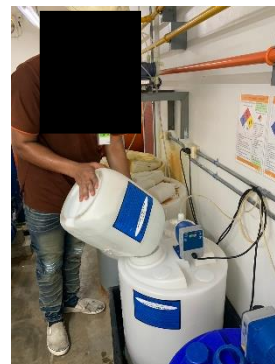
รูปที่ 13 ใช้สารชีวฆาตเพื่อควบคุมการเจริญเติบโตของตะไคร่ และสาหร่าย
