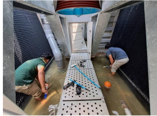
รูปที่ 35 การทำความสะอาด Cooling Tower
